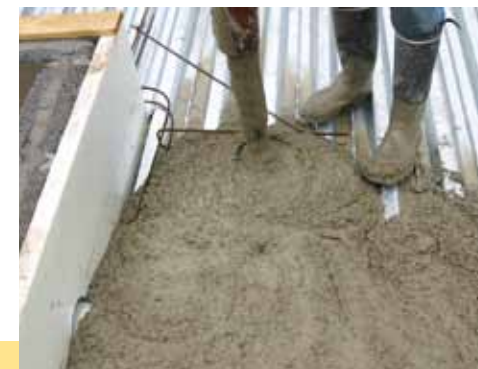
Betoni lasketaan ensin päätyjen ja välitukien kohdalle.
