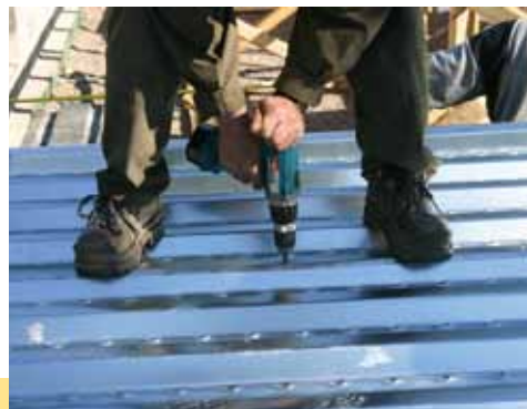
Levyjen kiinnitys porakärkiruuveilla max. väli 500 mm.
