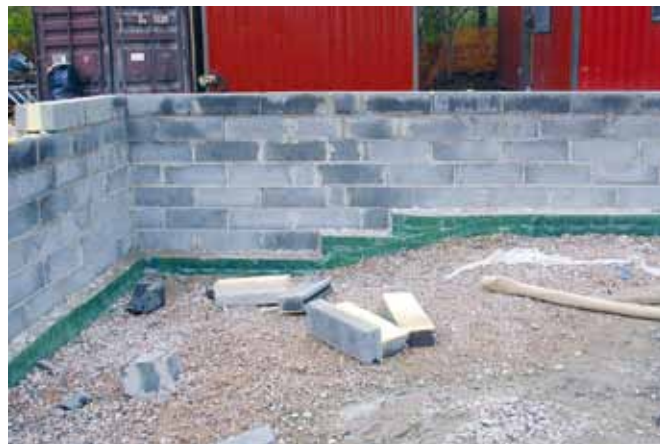
Portaittain toteutettu porrastus harkkoille.
