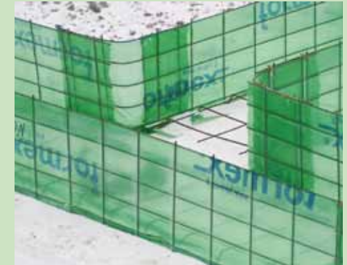
Kulmapalat voidaan taivuttaa haluttuun terävytyteen. Sidonta on tehtävä huolella koska valupaine kohdistuu juuri kulmiin ja T-liitoksiin.
