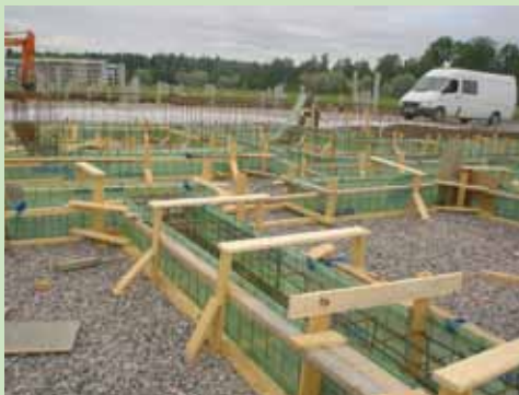
Valulevystä tehtäessä tuenta myös alhaalla.
