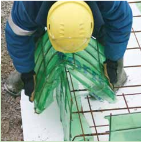
Kulmapalojen taivuttaminen käy helposti työnedetessä syntyvien palojen avulla.
