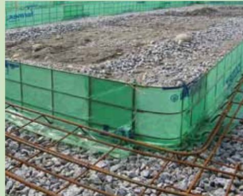
Kulmapalojen taivuttaminen käy helposti työnedetessä syntyvien palojen avulla.
