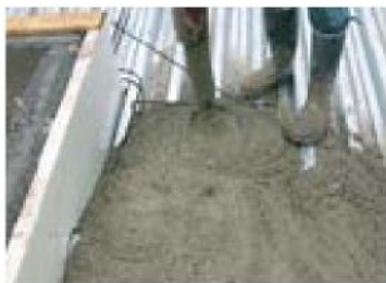
Betoni lasketaan ensin päätyjen ja välitukien kohdalle.
