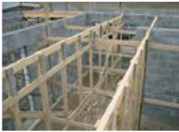
Puusta tehdyt tuet, joiden päälle liittolevyt asetetaan.
