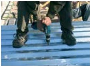
Levyjen kinnitys porakärkiruuvilla max. väli 500 mm.
