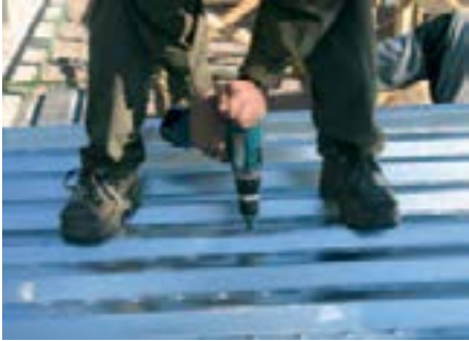
Levyjen kiinnitys porakärkiruuvveilla max. väli 500 mm.
