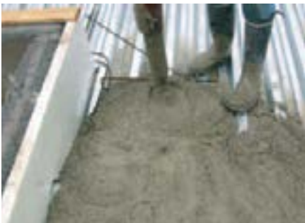
Betoni lasketaan ensin päätyjen ja välitukien kohdalle.
