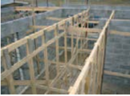
Puusta tehdyt tuet, joiden päälle liittolevyt asetetaan.
