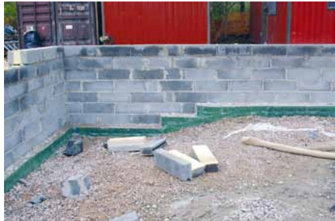
Portaittain toteutettu porrastus harkkoille.
